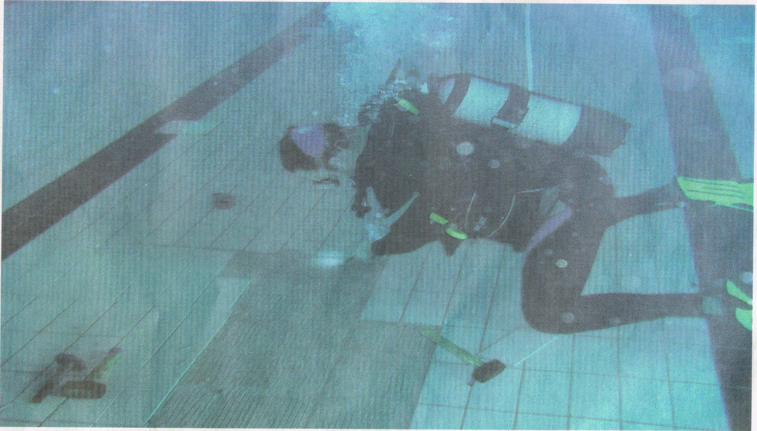
Arbeitsplatz unter Wasser: Im laufenden Betrieb können drei Hückeswagener Tüftler kaputte Fliesen in Schwimmbädern und Wellnessoasen austauschen. Das Verfahren haben sie in jahrelanger Kleinarbeit selbst entwickelt.
